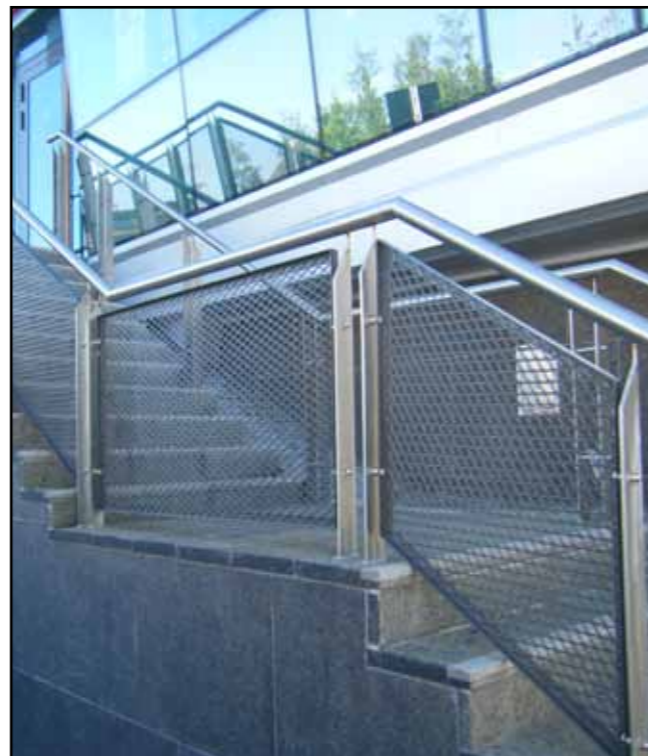
Räcket på bilden har extra tillval. (Handlöpare samt plattstålsstolpar i rostfritt)
