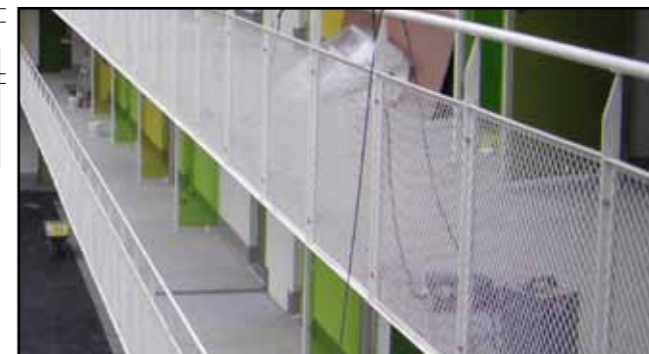
Räcket på bilden har extra tillval. (Krenulerat galler, stolpar av plattstål och bjälklagstäckande räckesfyllnad)
